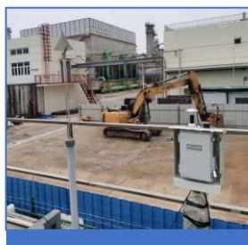
山東濰坊開發工業園區長期監測
